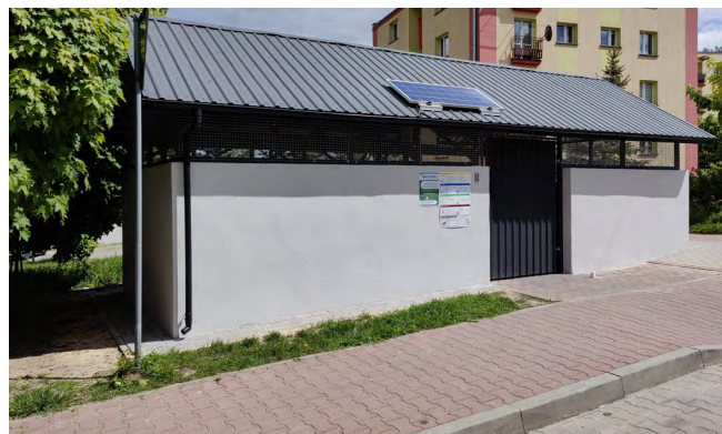
Wiata śmietnikowa przy ul. Białe Zagłębie
