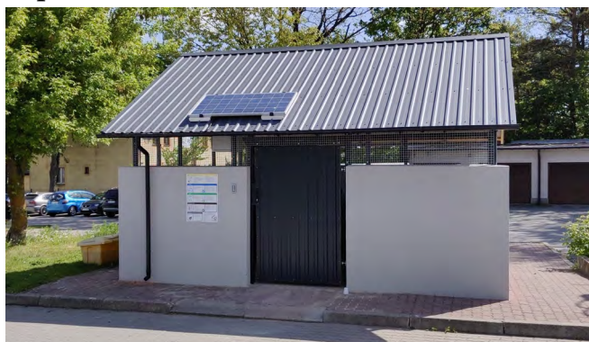
Wiata śmietnikowa przy ul. Parkowej
