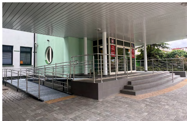
Modernizacja wejścia do urzędu
