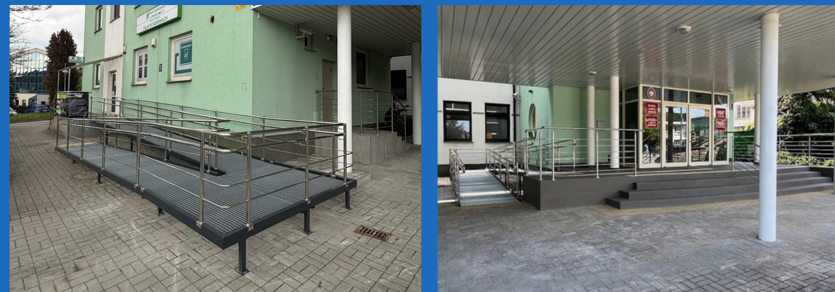
Modernizacja wejść od strony banku i urzędu
